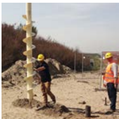
Figura B.17 - Vite continua.
