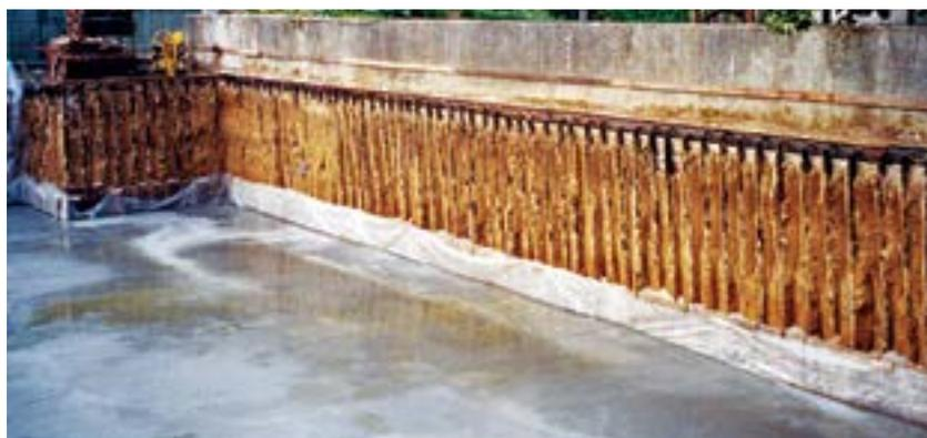
zione alle caratteristiche geotecniche dei terreni, in modo tale da consentire il verificarsi "dell'effetto arco" che faccia collaborare tutti i pali, a vantaggio della stabilità del fronte di scavo.
