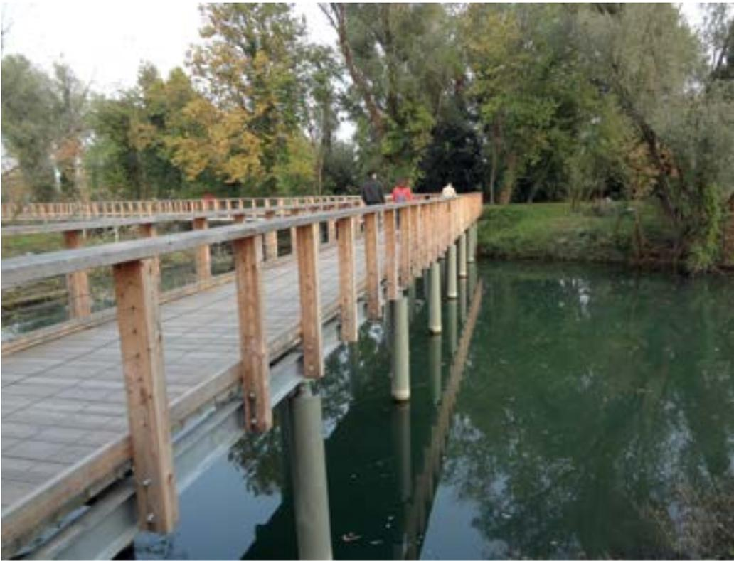
*Esempio di passerella ciclopedonale realizzata sul fiume Sile con elementi di acciaio e legno a basso impatto ambientale.*
