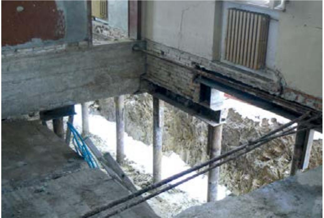
*Particolare della fase di sollevamento di una muratura da consolidare con criteri antisismici.*
