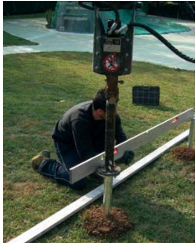
*Messa in opera di pali a vite Geopal® P2G 60 per la realizzazione di un impianto fotovoltaico da 3,50 kW.*
