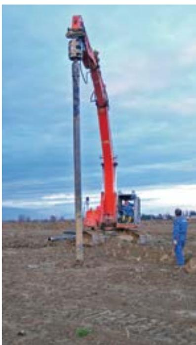
Figura F.14 - Parco macchine per la posa in opera di pali Geopal®.
