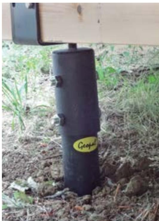
Strutture prefabbricate sostenute da pali Geopal®.
