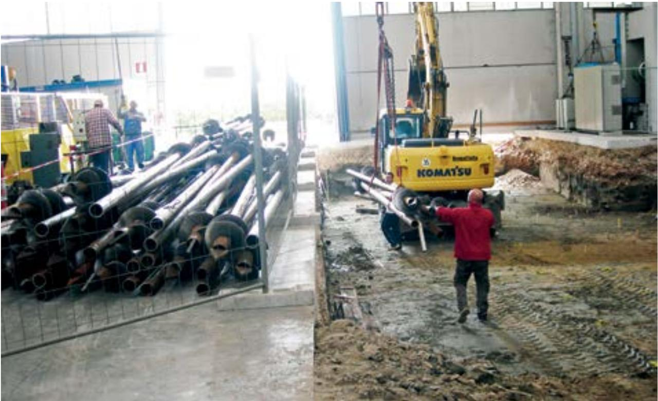
*Posa in opera di pali Geopal® a sostegno di un impianto industriale all'interno di capannone a Villamarzana (RO).*
