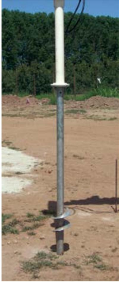
Campo fotovoltaico realizzato in Piemonte e sostenuto da pali Geopal® P2G.
