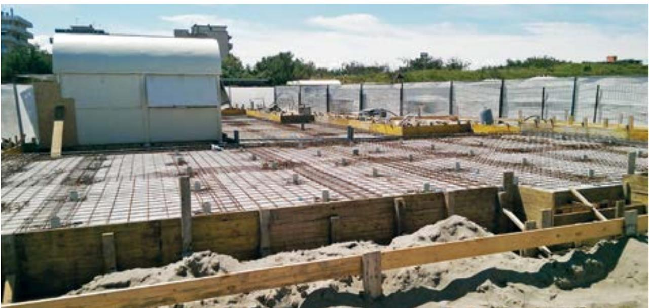
Fasi di posa in opera di pali Geopal® P2G e successivo agganciamento con plinto di fondazione, a sostegno di una torre di avvistamento nel parco naturale del Fiume Adige a Rosolina (Rovigo).
