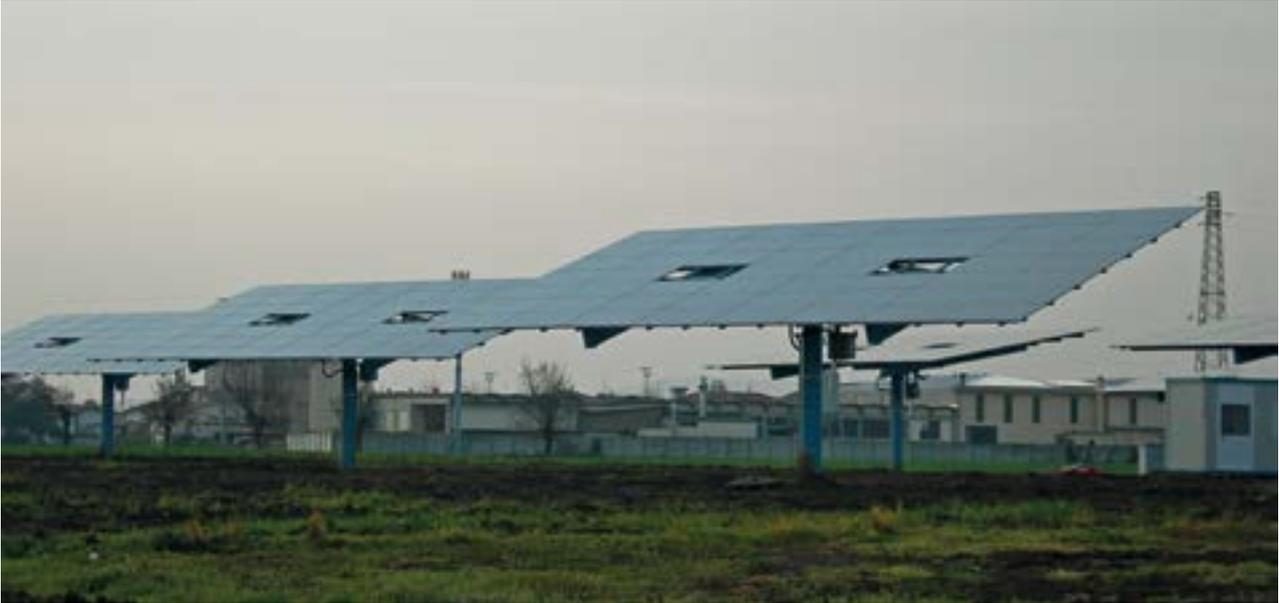
*Impianto fotovoltaico su tracker ancorato al suolo con pali a vite Geopal® PVD.*
