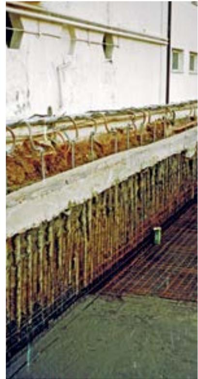
*Particolari di una palificata RSC eseguita ad Abano Terme per la realizzazione dei garage sotterranei di un albergo.*
