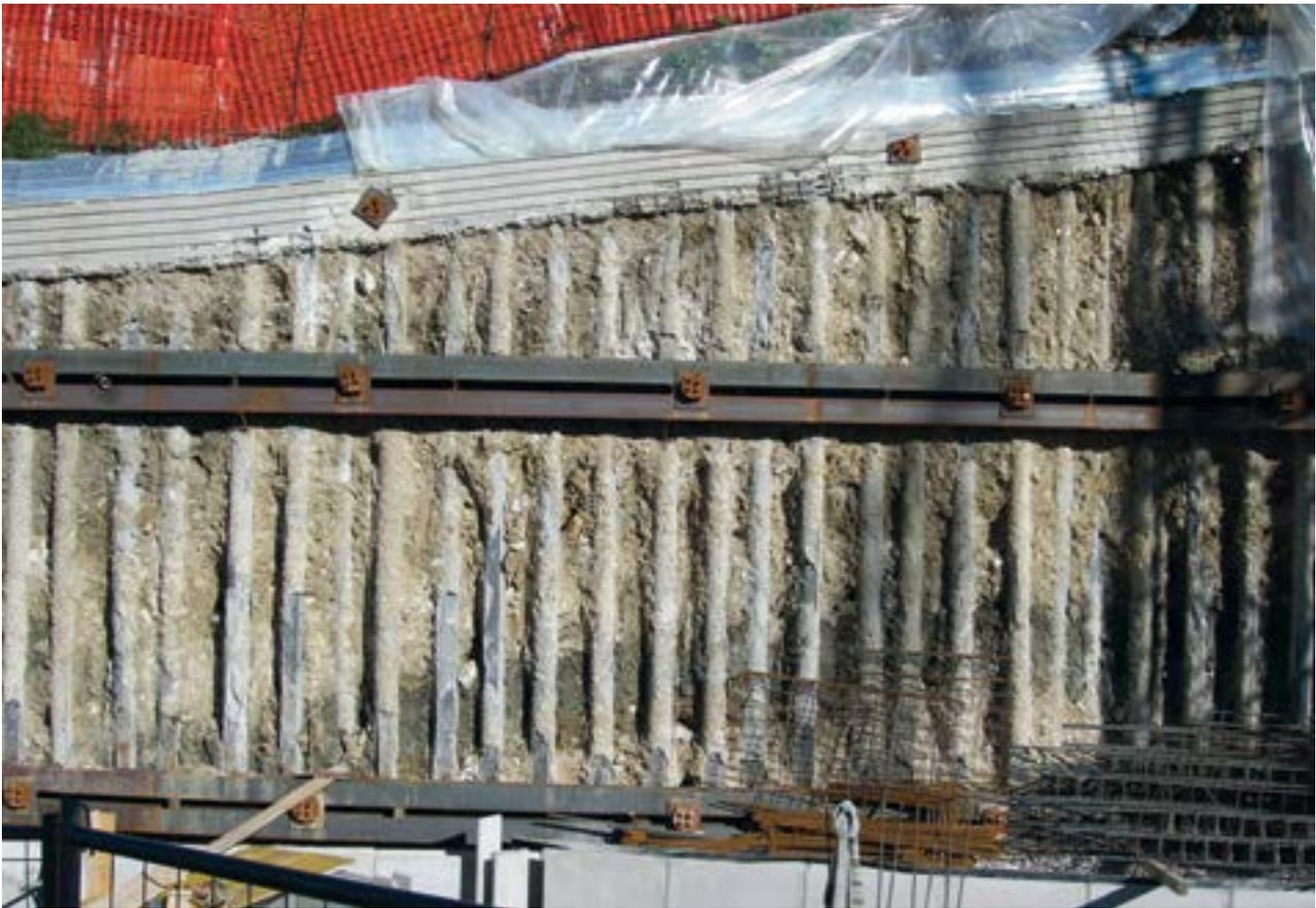
Esempi di palificata reggiscavo RSC eseguite con pali Geopal®.
