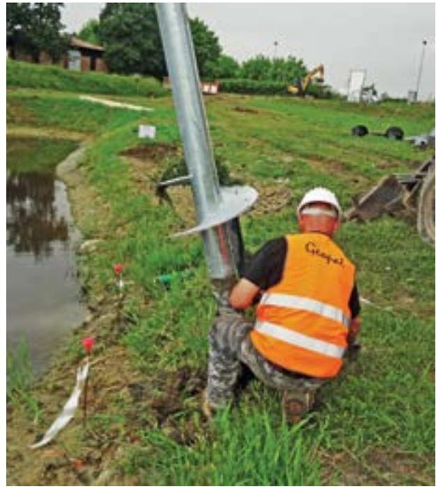
*Aggiunta di prolunghe zincate a caldo e armate con una vite di diametro 500 mm.*
