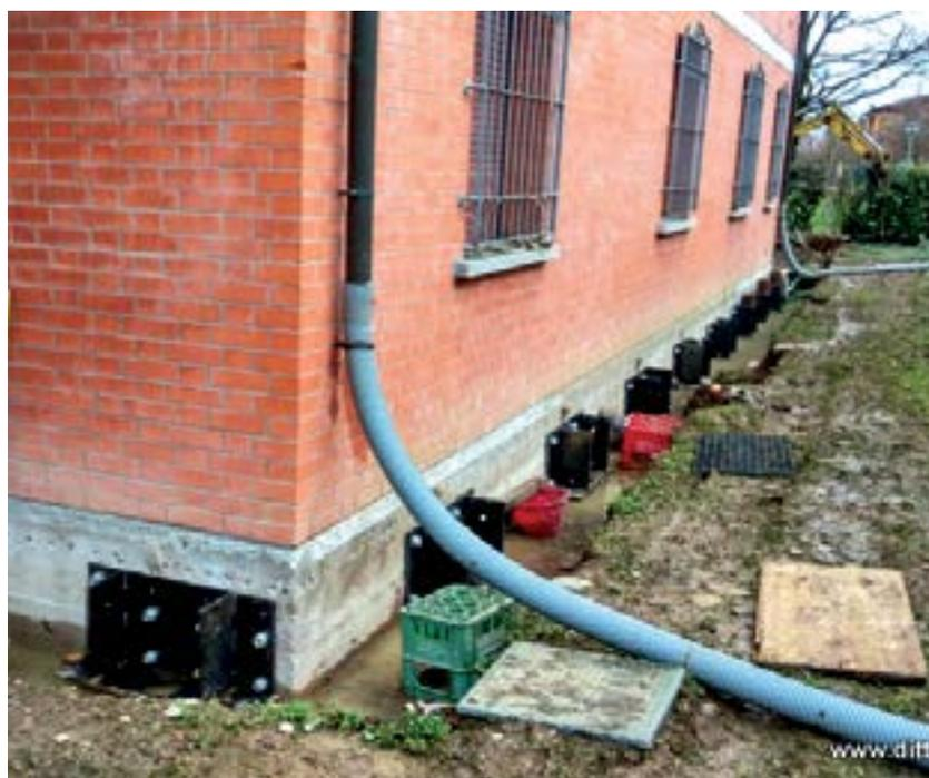
*Pre caricamento di pali fondazionali posti a perimetro di un edificio interessato da progetto di risanamento e sopraelevazione.*
