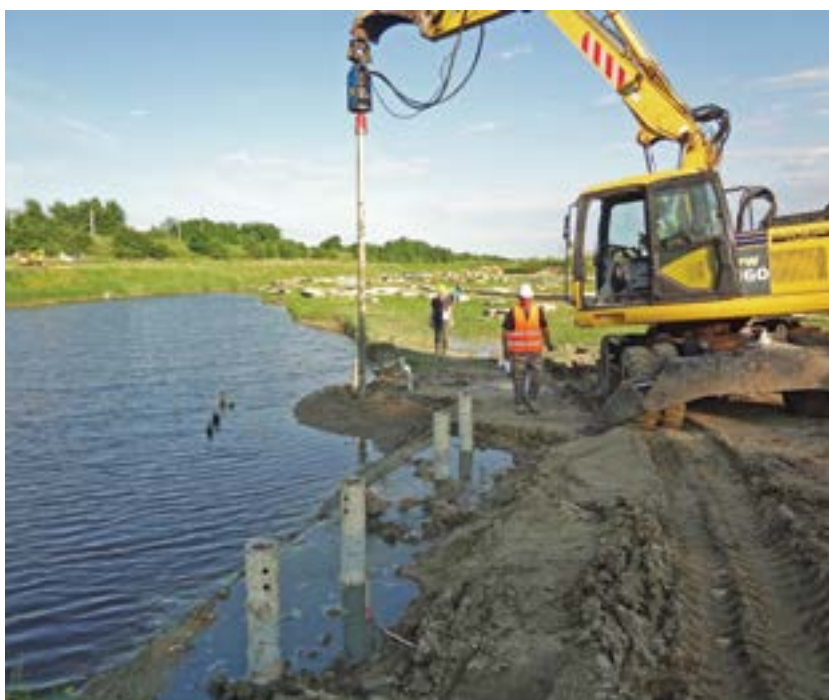
Figura F.16 - Infissione di pali PVD nel cantiere archeologico di Ravenna Antica (RA).
