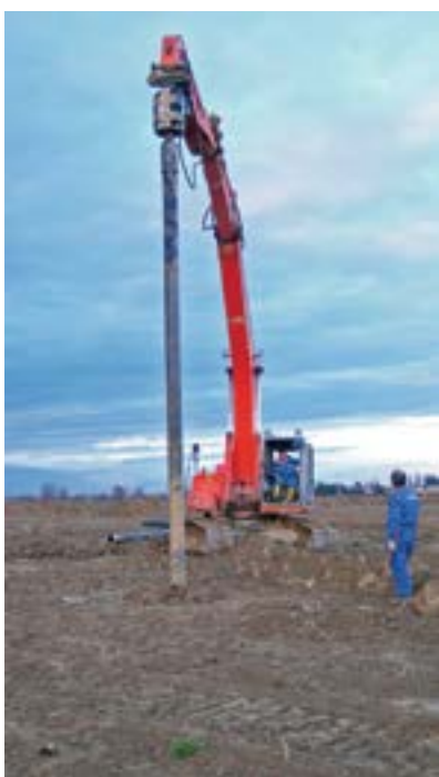
Figura F.15 - Escavatore durante l'infissione di un P2G sul passante di Mestre (VE).
