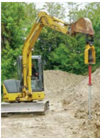
Figura F.15 - Escavatore durante l'infissione di un P2G sul passante di Mestre (VE).
