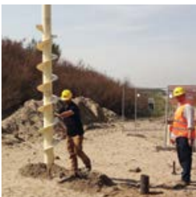
Figura B.17 - Vite continua.
