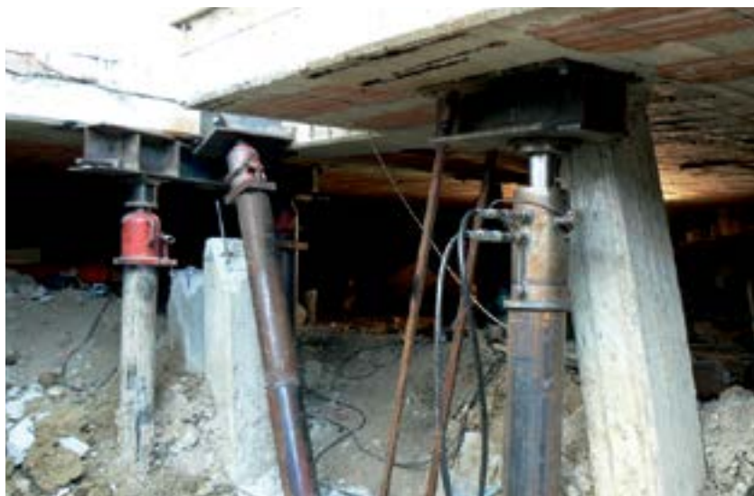
Pali di sottofondazione in fase di precaricamento a tonnellaggio di compensazione.
