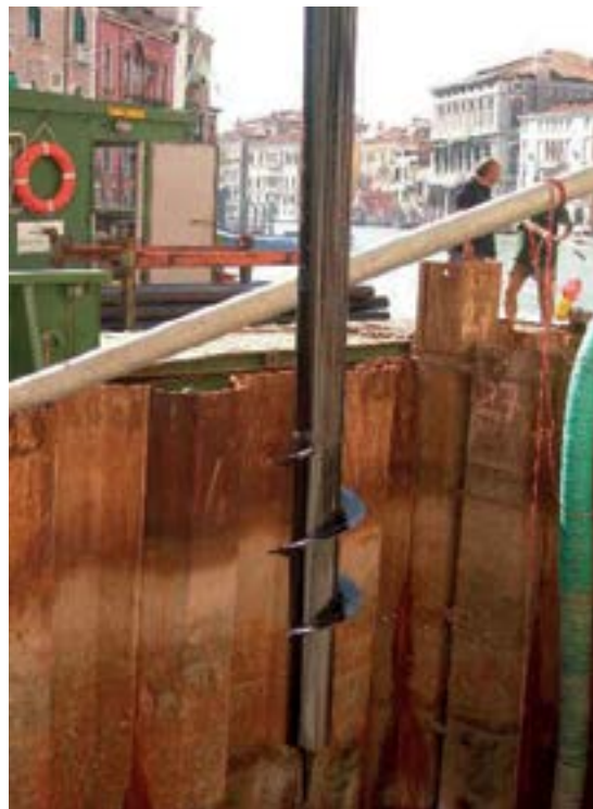
Consolidamento fondazionale di un edificio storico veneziano, situato sulla sponda destra del Canal Grande a Venezia.
