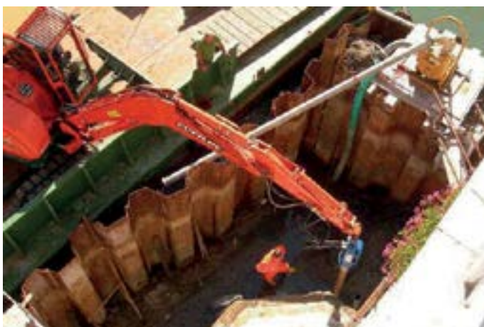
Consolidamento fondazionale di un edificio storico veneziano, situato sulla sponda destra del Canal Grande a Venezia.
