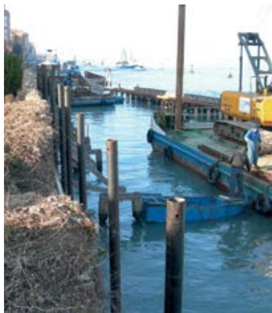
Palificata a sostegno di una cinta muraria di contenimento del terrapieno del giardino di un palazzo storico.
