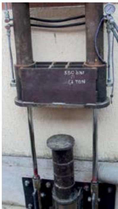
Precaricamento di pali fondazionali posti a perimetro di un edificio interessato da progetto di risanamento e sopraelevazione.
