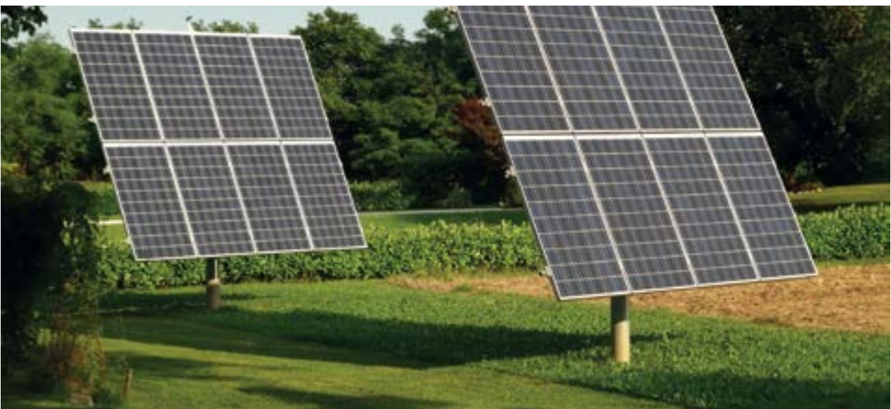
Inquadramento NW-SE di un tracker fotovoltaico fondazionato su pali Geopal® - Minitracker sostenuti da monopalo Geopal® P2G.
