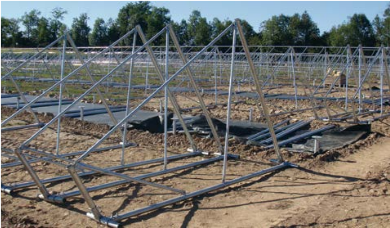
Campo fotovoltaico realizzato in Piemonte e sostenuto da pali Geopal® P2G.
