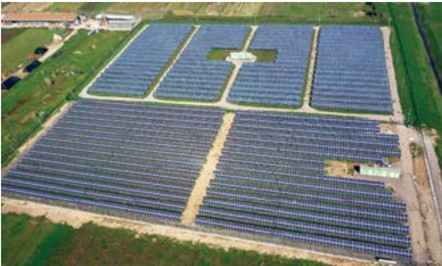
Impianto fotovoltaico sostenuto da pali a vite Geopal® P2G 140. Si noti il basso grado di impatto ambientale.
