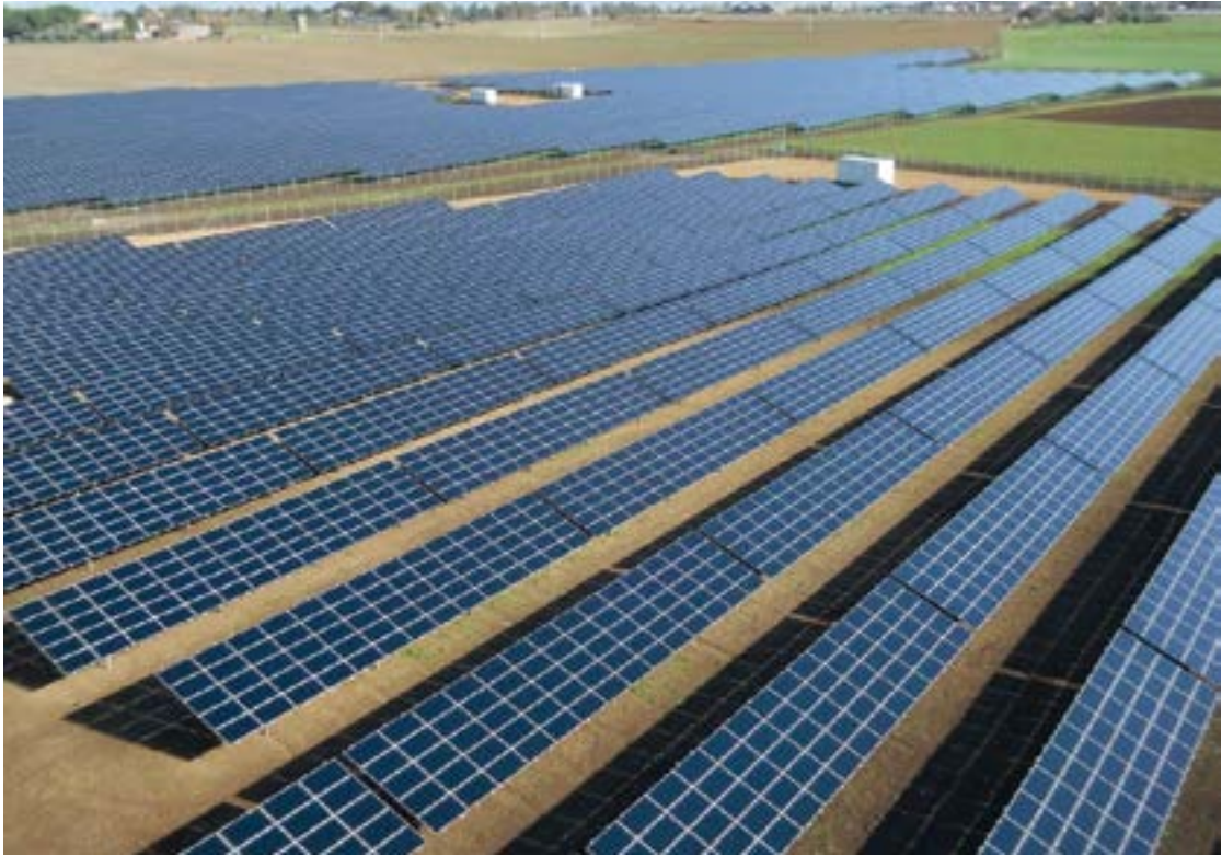
Impianto fotovoltaico sostenuto da pali a vite Geopal®.
