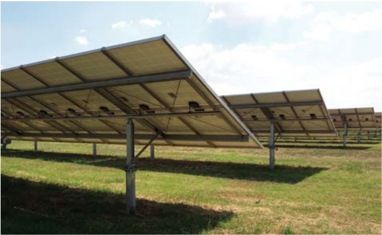
Impianto fotovoltaico sostenuto da pali a vite Geopal® P2G 140. Si noti il basso grado di impatto ambientale.
