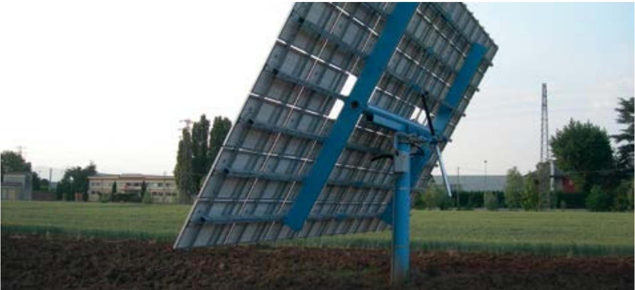
Inquadramento NW-SE di un tracker fotovoltaico fondazionato su pali Geopal® - Minitracker sostenuti da monopalo Geopal® P2G.
