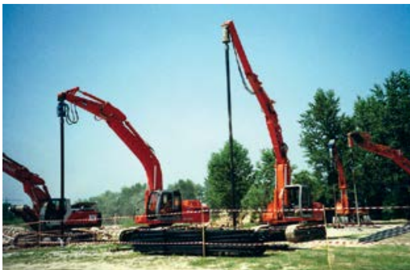
Figura F.16 - Infissione di pali PVD nel cantiere archeologico di Ravenna Antica (RA).
