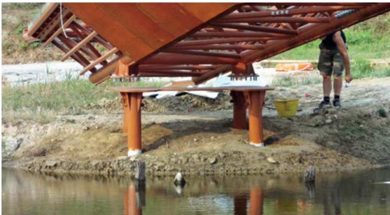
Vista della parte inferiore del ponte, durante la fase di piazzamento sugli appoggi d'acciaio realizzati sulle teste dei pali Geopal®.
