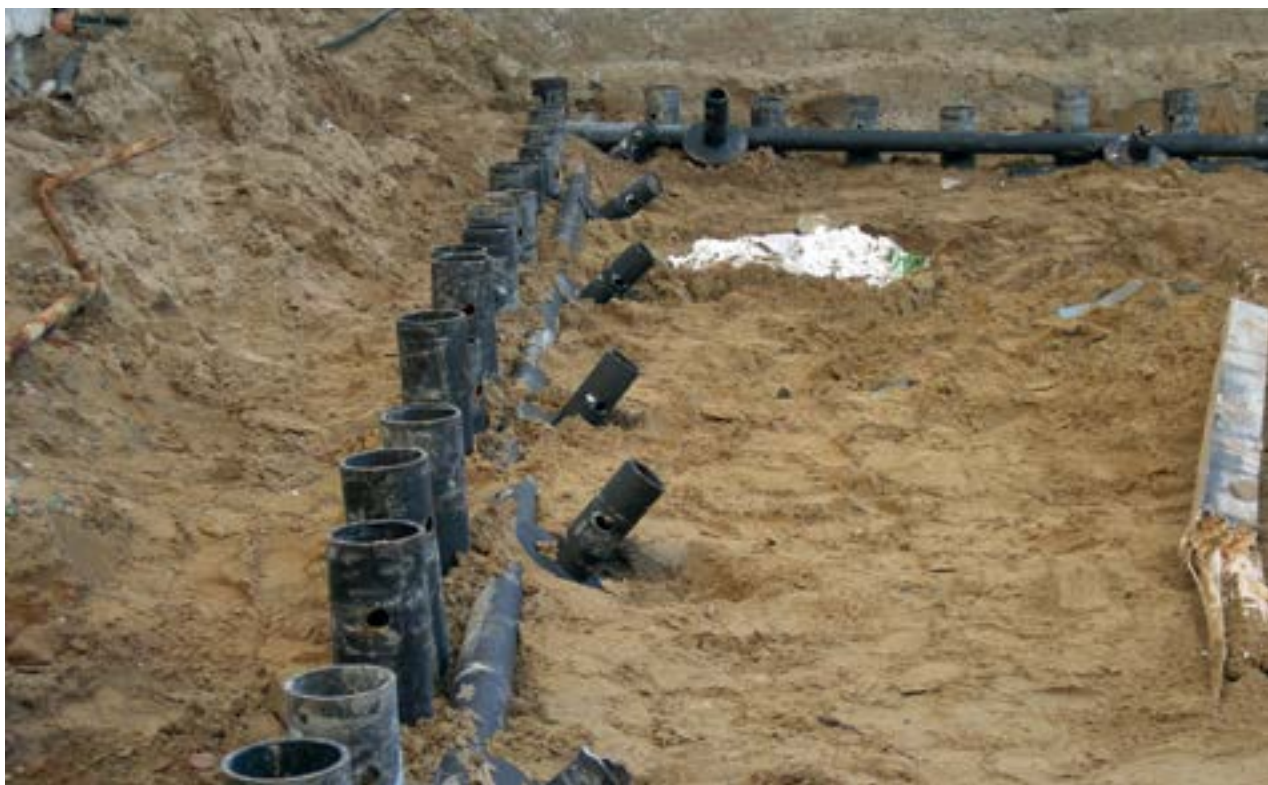
Posa in opera di una palificata tipo "berlinese" realizzata a Jesolo Lido (VE).
