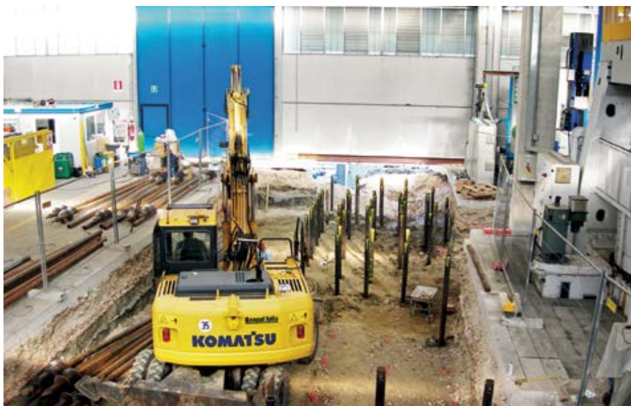
Posa in opera di pali Geopal® a sostegno di un impianto industriale all'interno di capannone a Villamarzana (RO).
