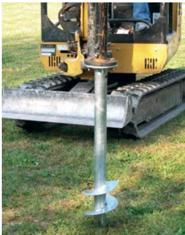
Messa in opera di pali a vite Geopal® P2G 60 per la realizzazione di un impianto fotovoltaico da 3,50 kW.
