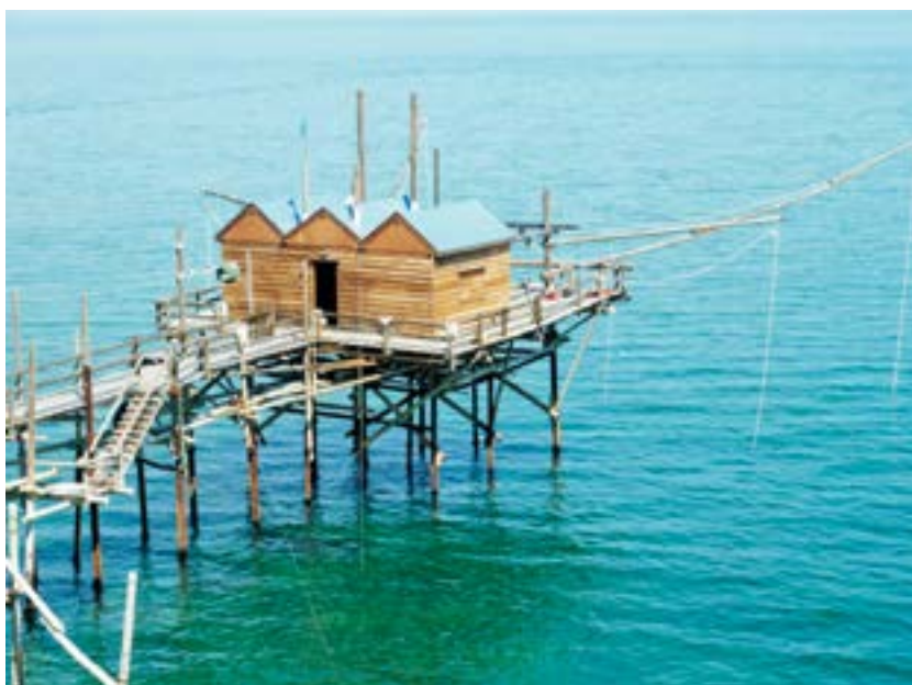
Trabucco sul mare sostenuto da pali Geopal®.
