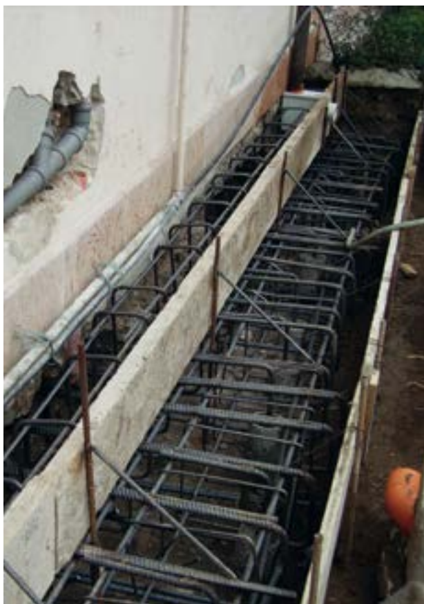
Particolare sul collegamento dei ferri di armatura del cordolo con la testa dei pali a vite.
