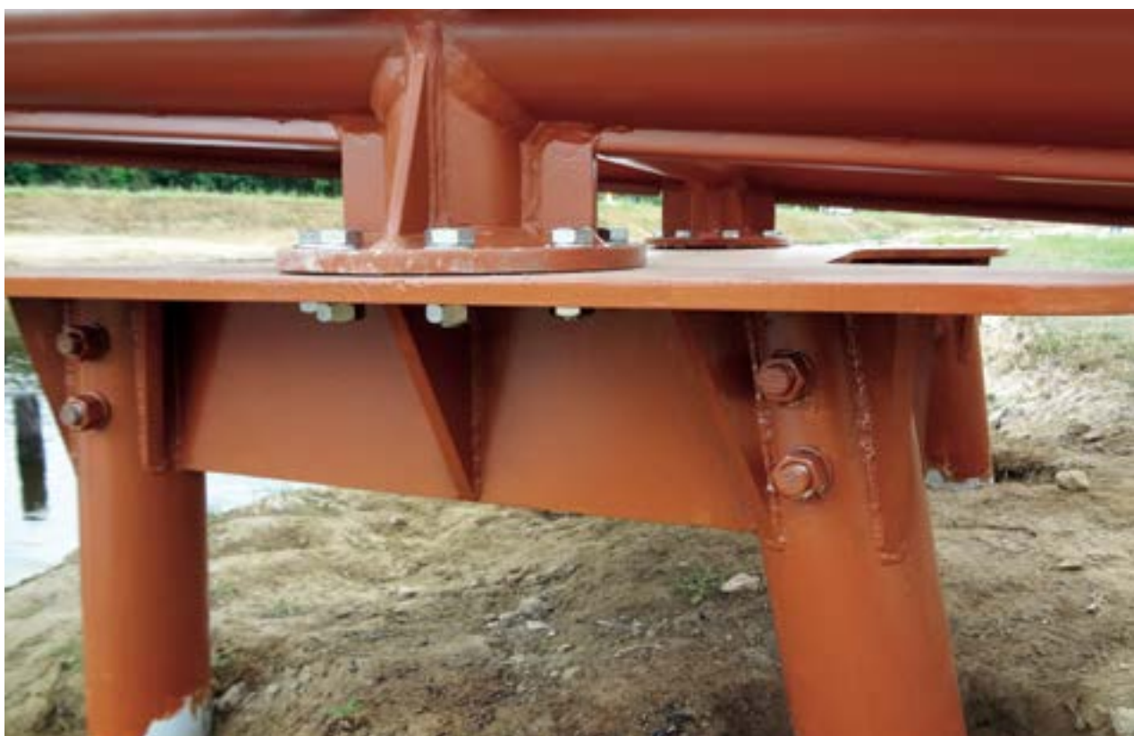
Particolare del fissaggio della struttura aerea del ponte ad una base di appoggio. Notare la soluzione adottata per rendere solidali le strutture ancorate al suolo.
