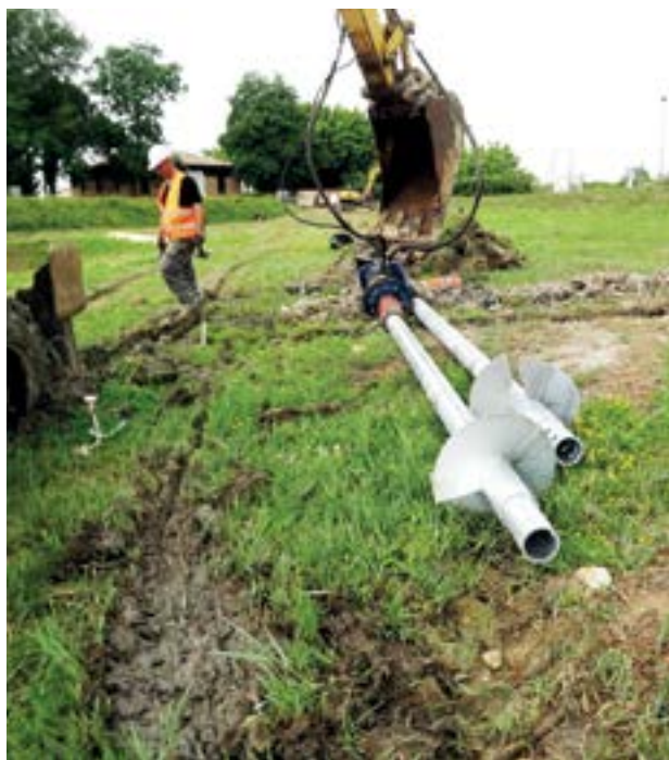
Aggiunta di prolunghe zincate a caldo e armate con una vite di diametro 500 mm.
