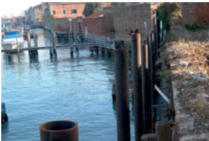
Palificata a sostegno di una cinta muraria di contenimento del terrapieno del giardino di un palazzo storico.
