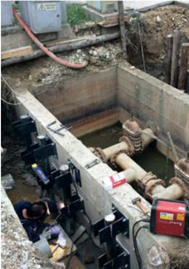
Consolidamento di una vasca di alloggiamento pompe idrauliche dell'acquedotto di Jesolo - Venezia (2014).
