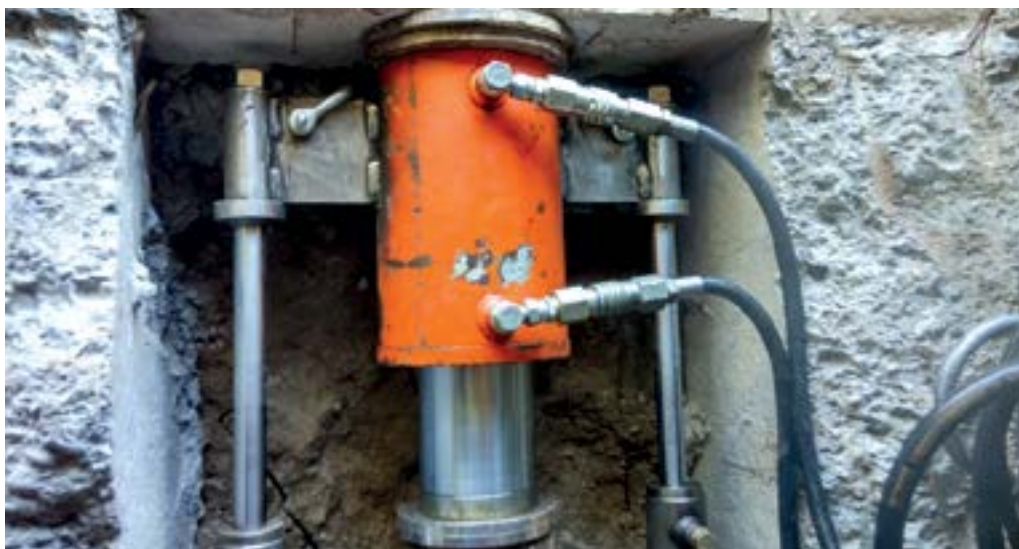
Particolare di precaricamento di un palo fondazionale infisso in corrispondenza di un punto critico.
