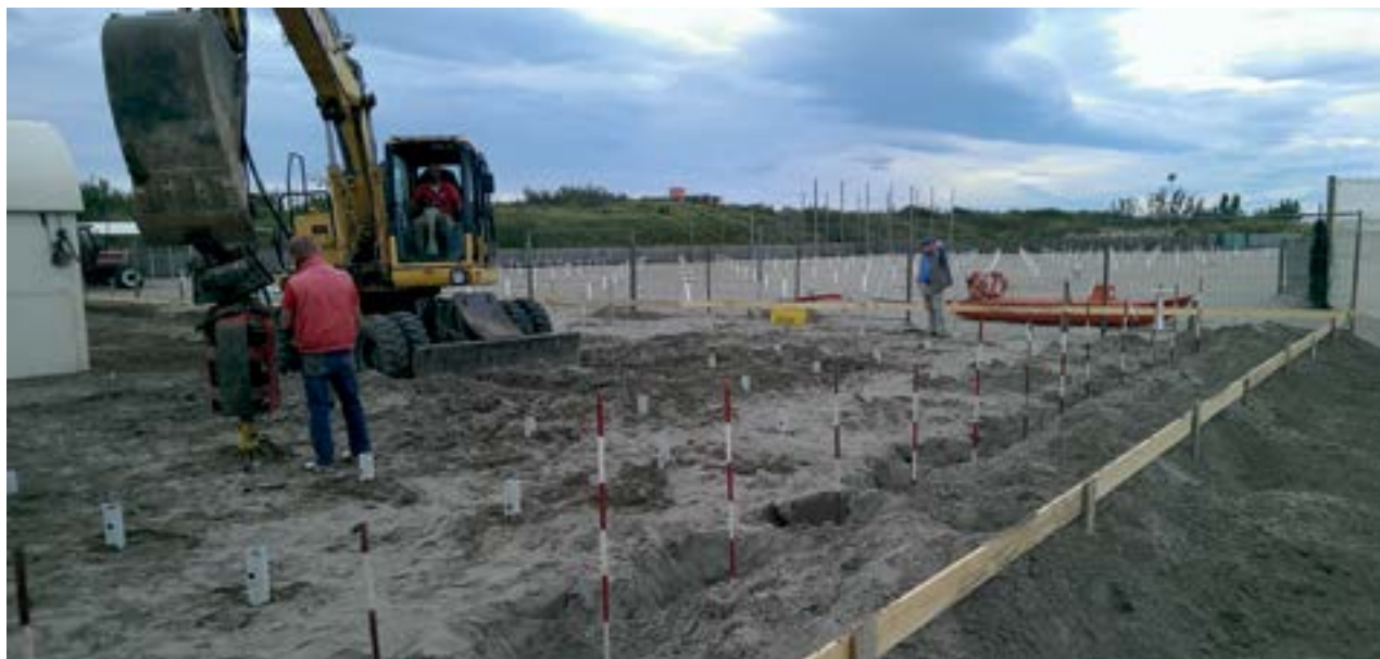
Pali Geopal® utilizzati come fondazione per un nuovo ristorante sulla spiaggia a Chioggia-Venezia.
