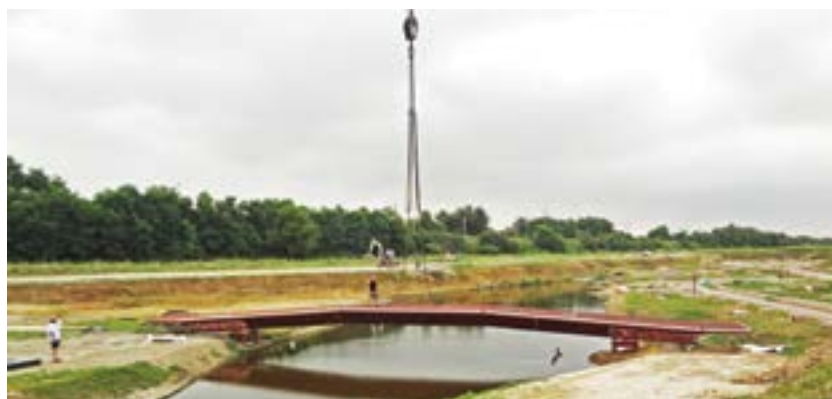
Figura E.22 - Inquadramento generale della posa in opera di un ponte in acciaio, realizzato da Geopalitalia e sostenuto da pali Geopal® PVD.
