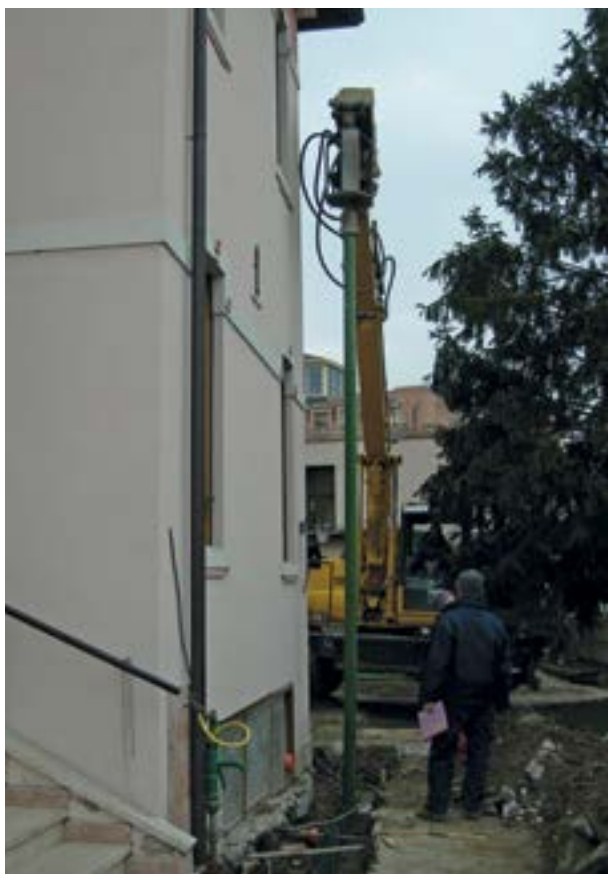
Intervento di consolidamento fondazionale di un edificio soggetto a cedimenti.
