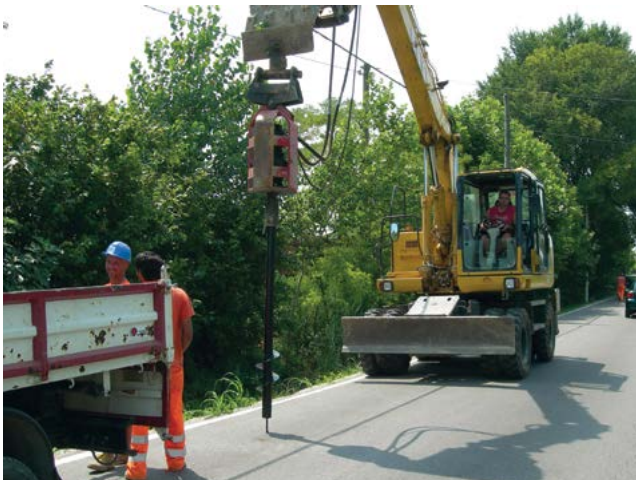
Particolare di posa in opera di pali fondazionali lungo scarpata stradale per il sostegno dei tralicci dell'illuminazione pubblica a Mirano (VE).
