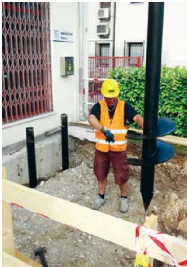
Utilizzo dei pali Geopal® mod. PVD per ampliamento di fabbricato industriale in località Vicenza.
