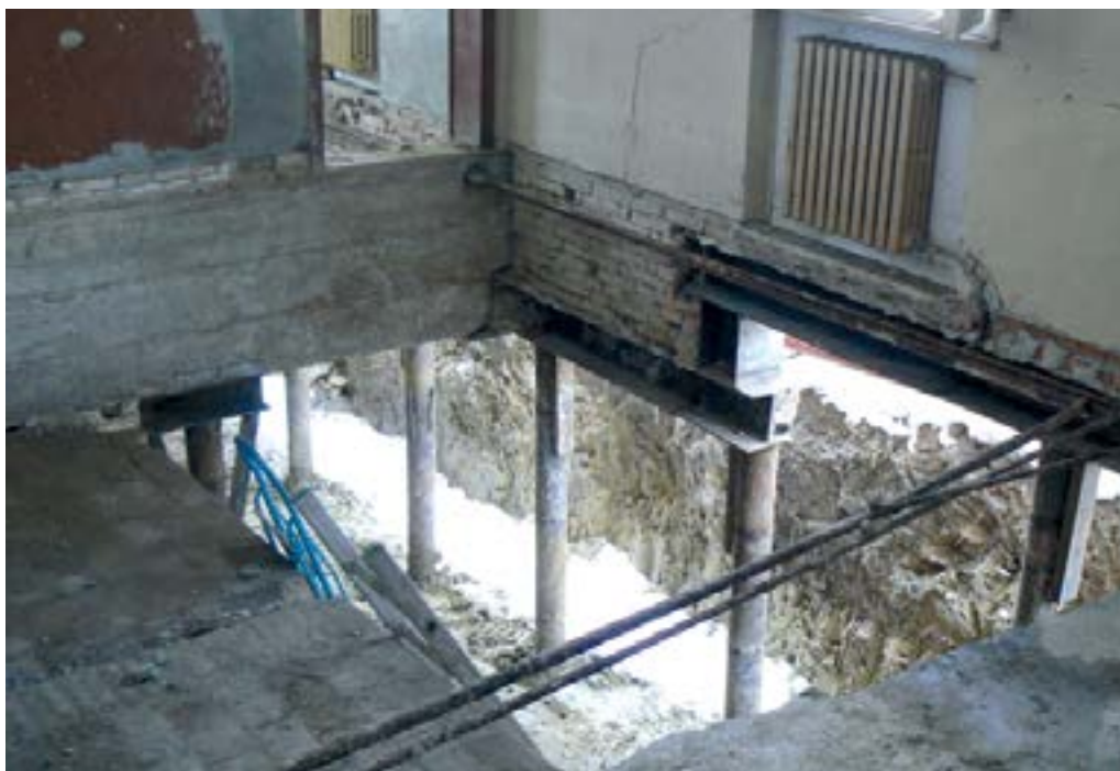
Particolare della fase di sollevamento di una muratura da consolidare con criteri antisismici.
