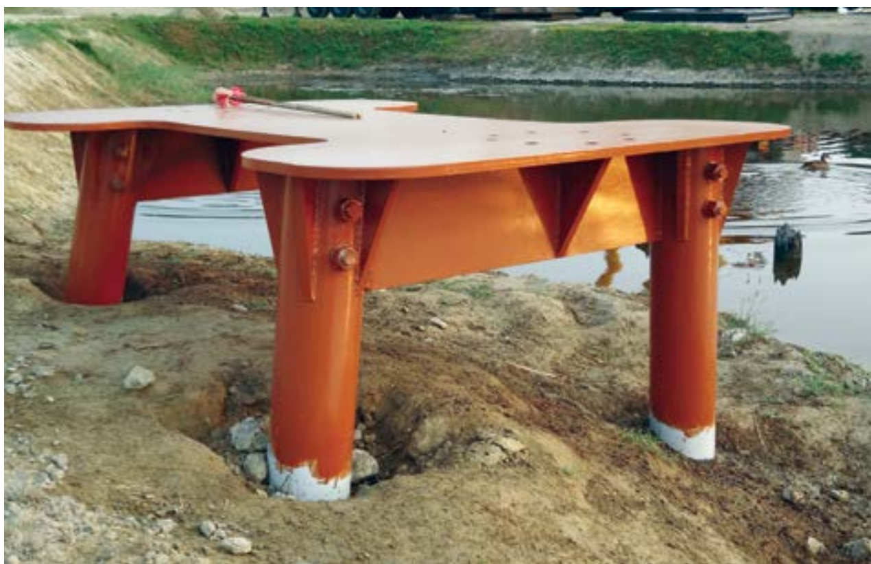
Particolare di una spalletta del ponte costituita da pali a vite Geopal® mod. PVD di lunghezza 10 metri, armati con eliche distanziate di \Phi 500 mm.
