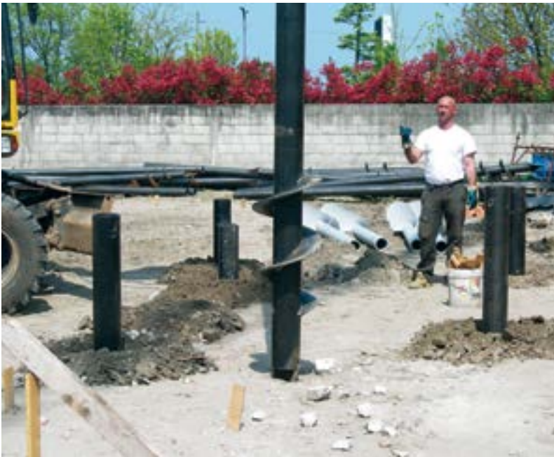
Pali Geopal® mod. P2GPVD impiegati come fondazione per la nuova costruzione di una nuova costruzione commerciale in località Chioggia - Venezia.
