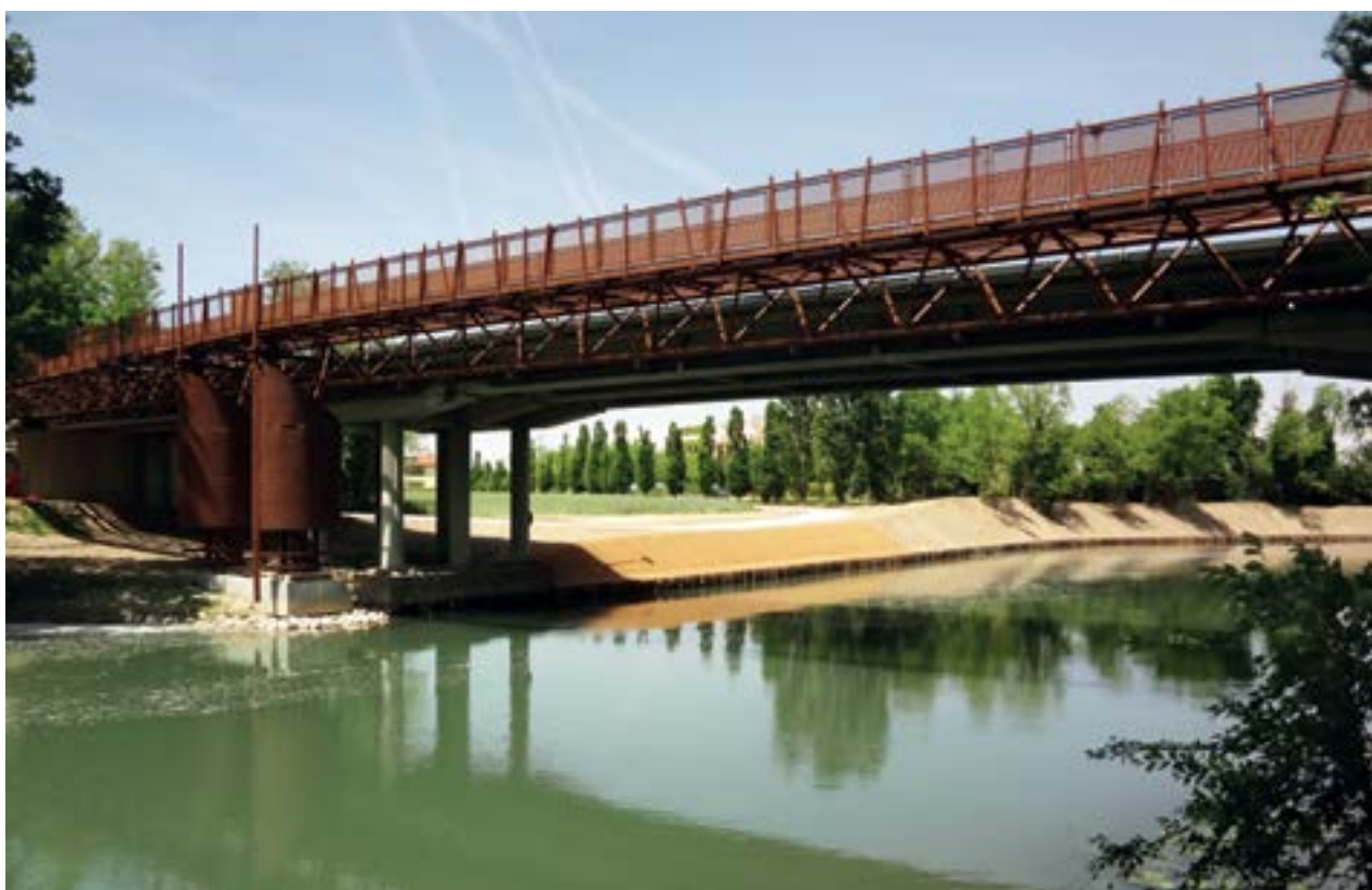
Ponte su fiume Sile in loc. Belvedere a Casale sul Sile (TV) sostenuto da fondazioni su pali d'acciaio a vite Geopal® ad alta capacità portante.
