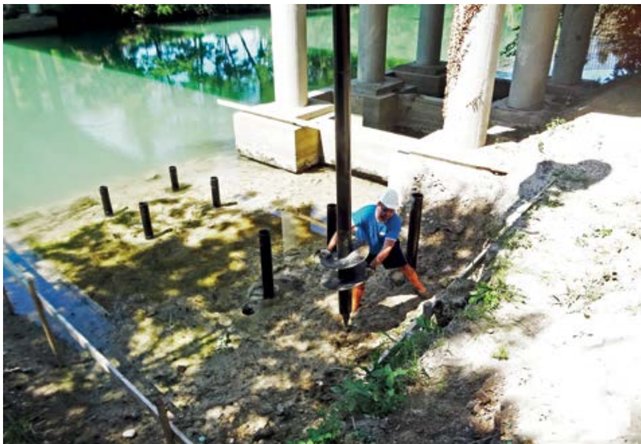
Infissione dei pali fondazionali Geopal® mod. PVD dentro il perimetro dello zoccolo fondazionale.
