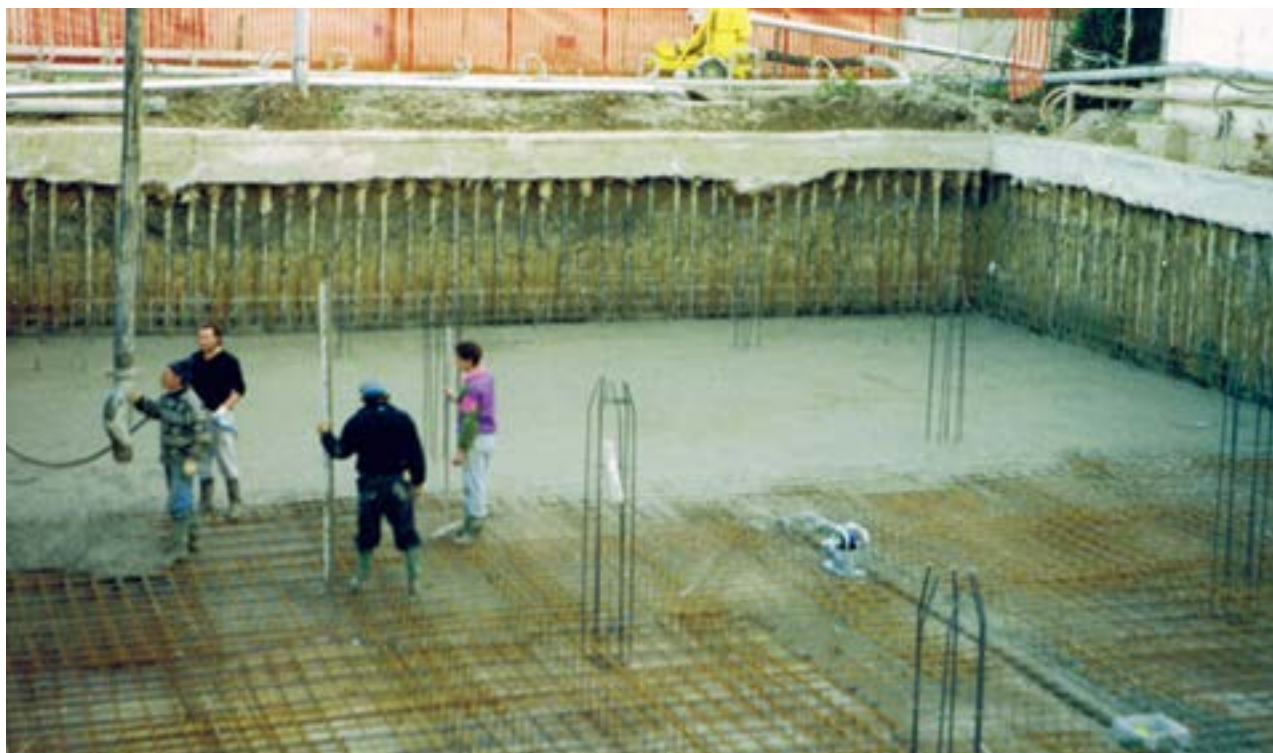
Getto platea in calcestruzzo dei garage.
