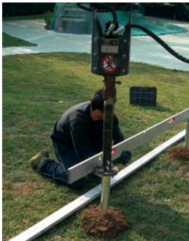
Messa in opera di pali a vite Geopal® P2G 60 per la realizzazione di un impianto fotovoltaico da 3,50 kW.
