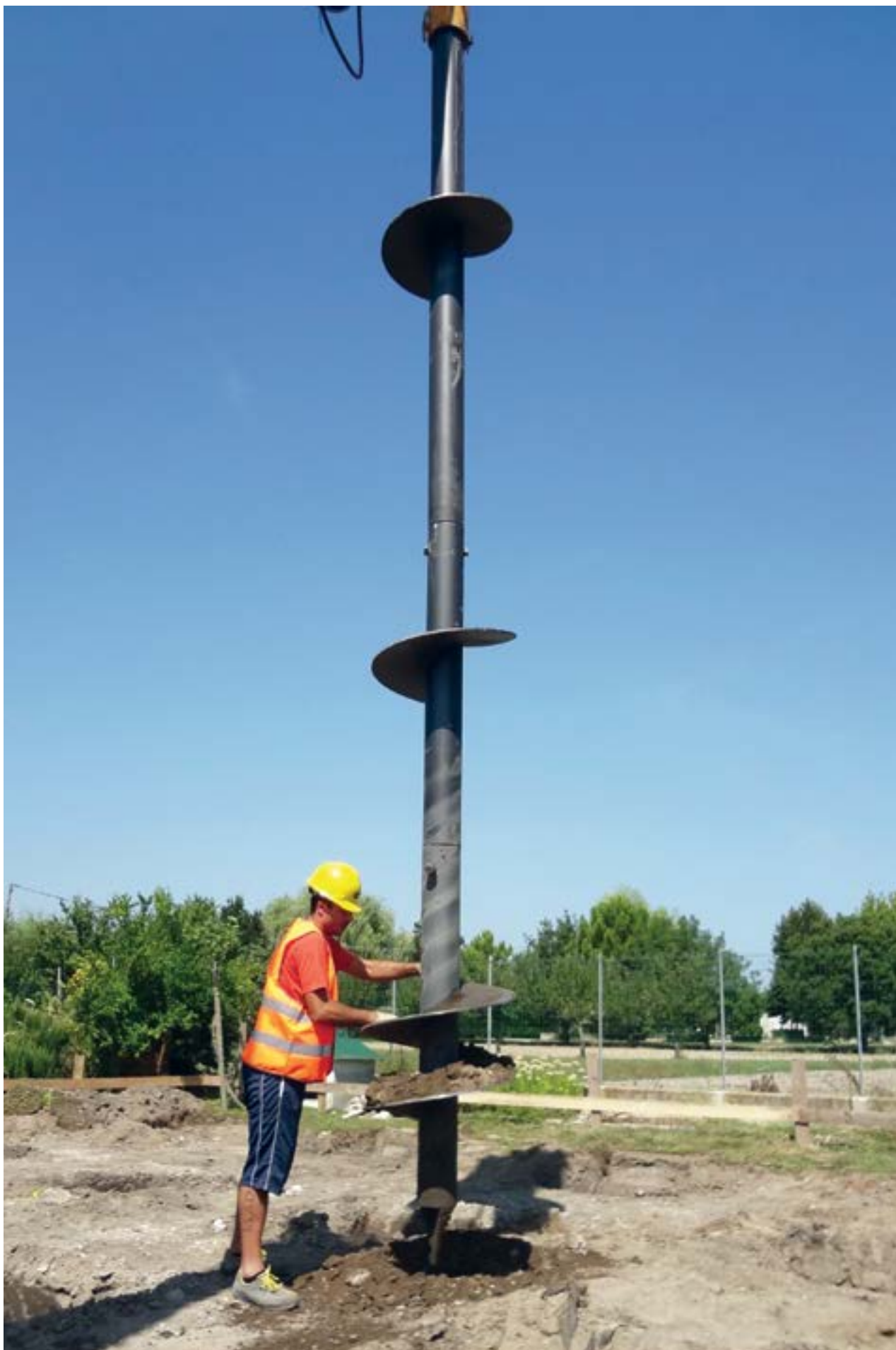
Paio Geopal® ad alta capacità portante PVD 168 utilizzato in un cantiere a Chioggia (VE).
