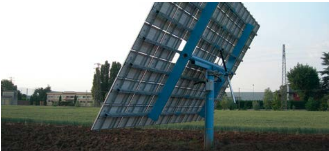
Inquadratura NW-SE di un tracker fotovoltaico fondazionato su pali Geopal® - Minitracker sostenuti da monopalo Geopal® P2G.
