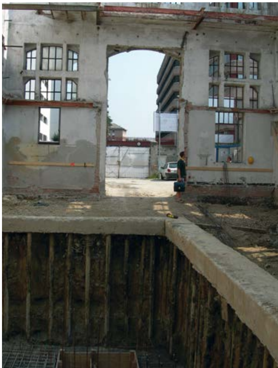
Esempio di palificata RSC interna ad un fabbricato da restaurare.
