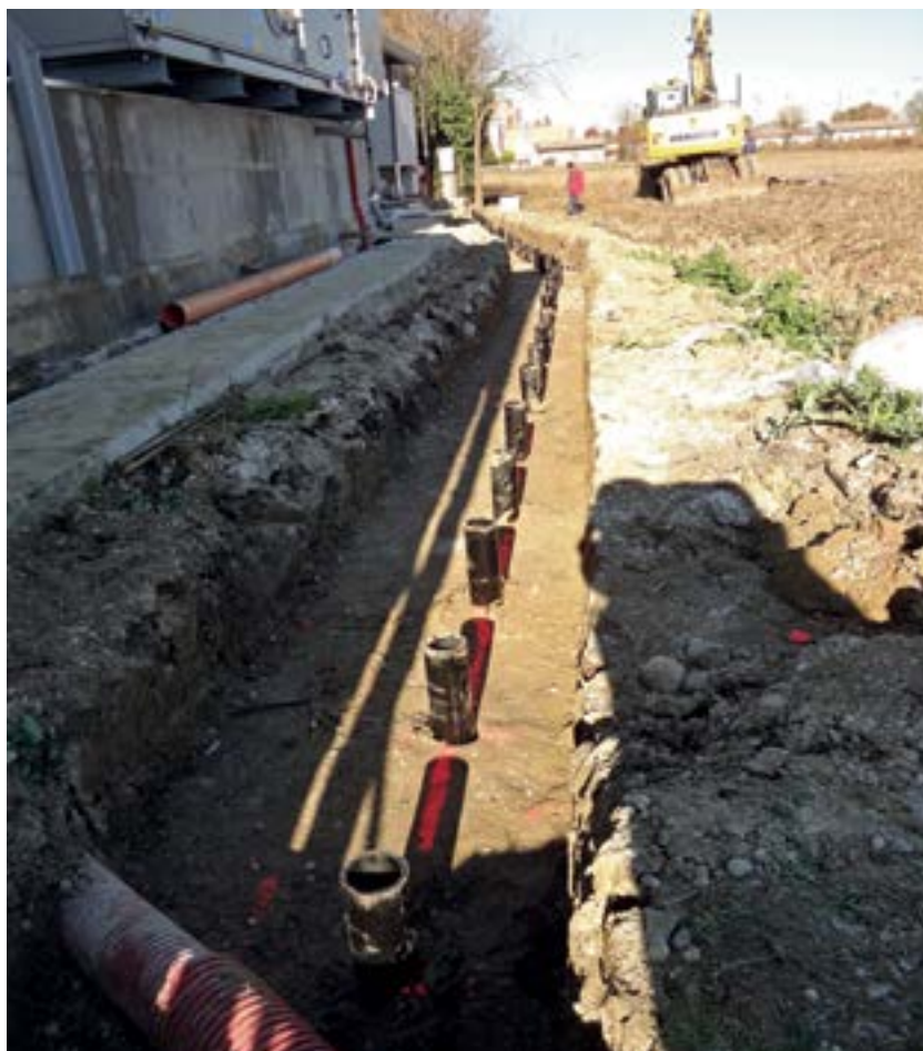
Palificata RSC di protezione a un impianto di cisterne di prodotti infiammabili stoccati in un'area industriale di Mestre (VE).
