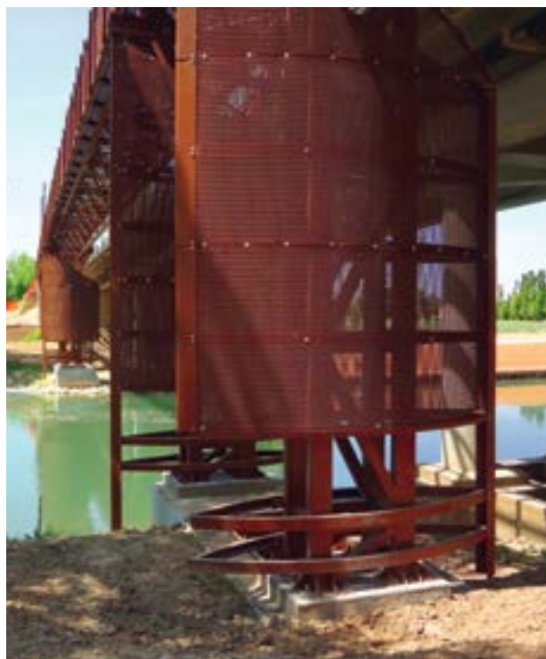
Pile fondazionali poggianti su pali a vite Geopal® mod. PVD posti a sostegno del ponte ciclopedonale sul fiume Sile a Casale sul Sile (TV).
