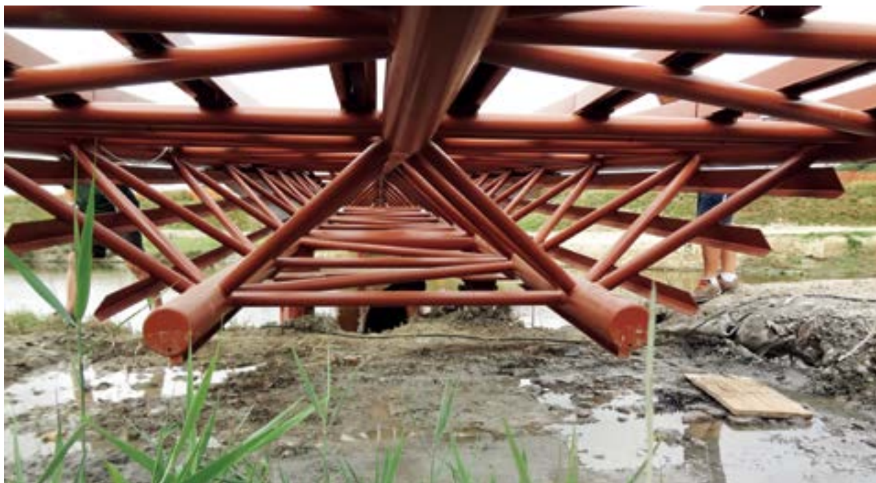
Particolare del telaio reticolare del ponte.
