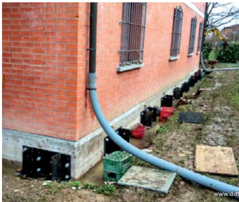
Precaricamento di pali fondazionali posti a perimetro di un edificio interessato da progetto di risanamento e sopraelevazione.
