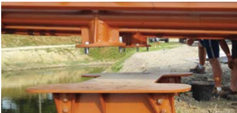
Figura E.23 - Particolare della fase di aggancio dei palotiranti Geopal® con il ponte in acciaio realizzato da GeopalItalia per il sito archeologico di Ravenna Antica.
