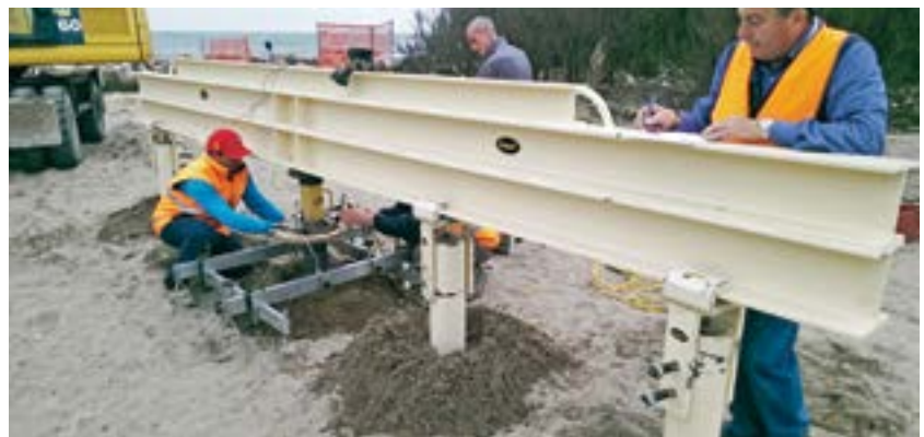
Figura E.29 - Fase esecutiva di una prova di carico a compressione eseguita su palo Geopal® PVD su terreni argillosi a Ravenna.
