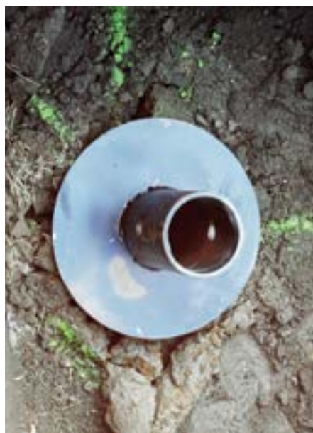
Pali a vite Geopal® mod. PVC utilizzati come fondazione per la nuova costruzione di porzione di fabbricato civile in località Sant'Anna di Chioggia - Venezia.
