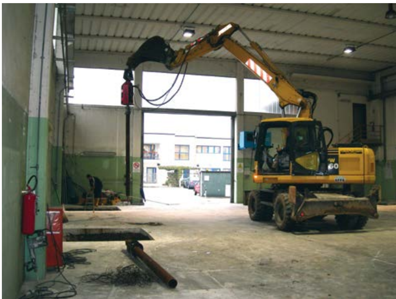
Pali a vite Geopal® utilizzati all'interno di un capannone industriale - Ristrutturazione ed ampliamento.
