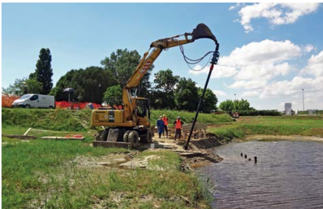
Fase d'infissione pali Geopal® mod. PVD inclinati e verticali.
