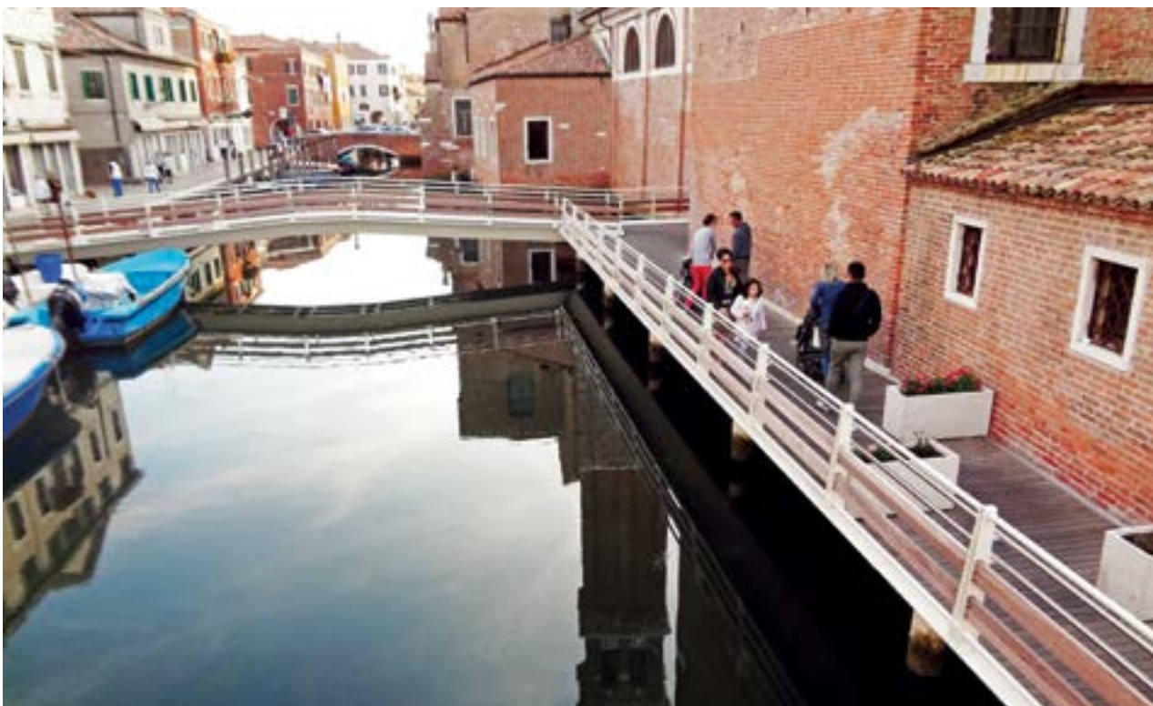
Passerella pedonale sostenuta da pali Geopal® P2G a Chioggia (VE).
