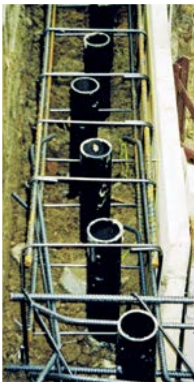
Particolari di una palificata RSC eseguita ad Abano Terme per la realizzazione dei garage sotterranei di un albergo.
