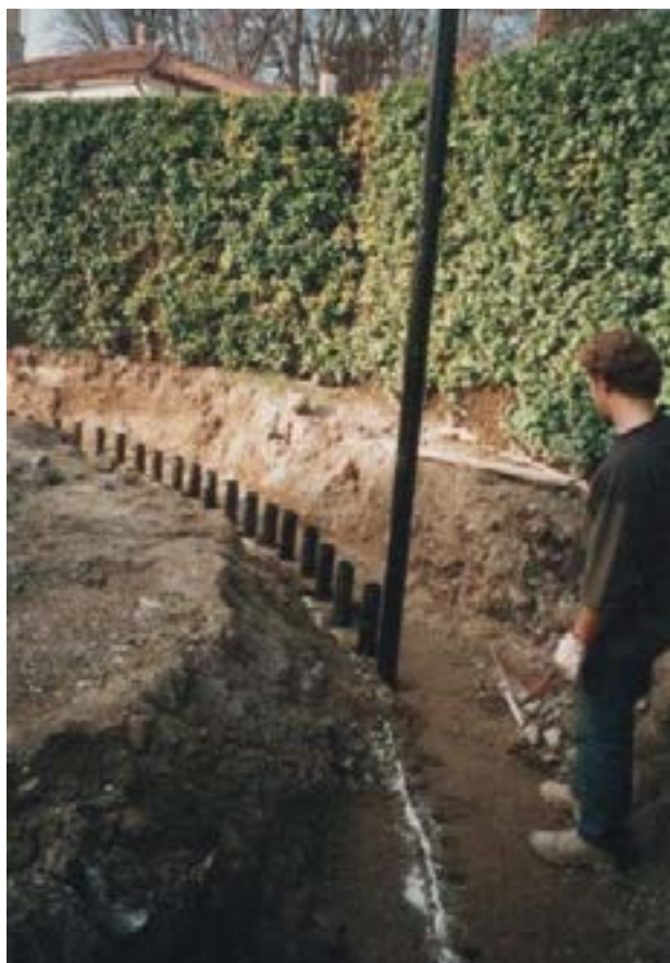
Posa in opera di pali a vite Geopal® disposti a perimetro di un'area da scavare a confine di proprietà.
