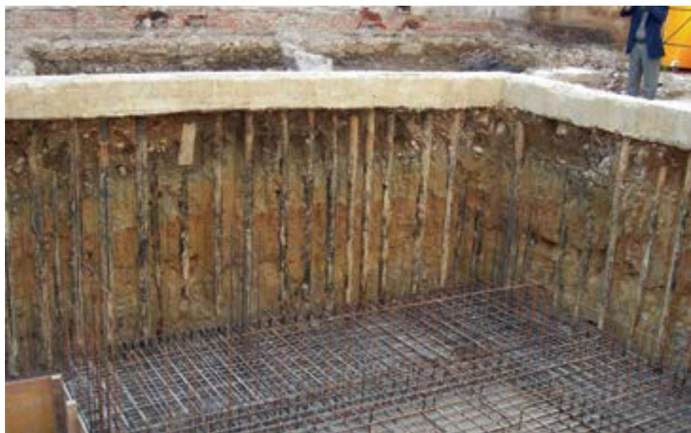
Esempio di palificata RSC interna ad un fabbricato da restaurare.
