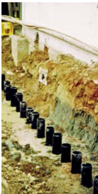
Particolari di una palificata RSC eseguita ad Abano Terme per la realizzazione dei garage sotterranei di un albergo.
