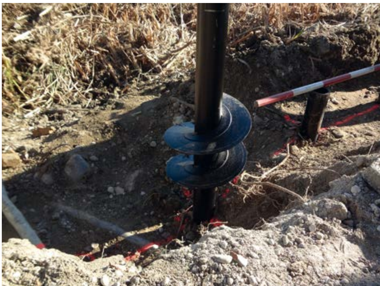
Palificata RSC di protezione a un impianto di cisterne di prodotti infiammabili stoccati in un'area industriale di Mestre (VE).
