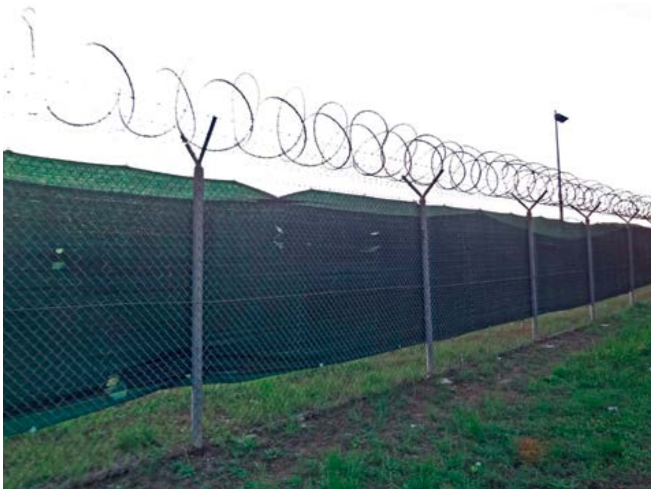
Recinzione militare sostenuta da pali Geopal® P2G. Si noti il basso impatto ambientale dovuto all'assenza di calcestruzzo.
