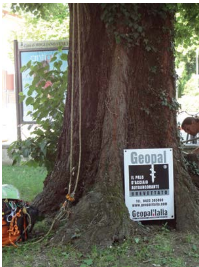
Messa in sicurezza del taglio secolare presente lungo la SS Pontebbana a Mogliano Veneto (TV).
