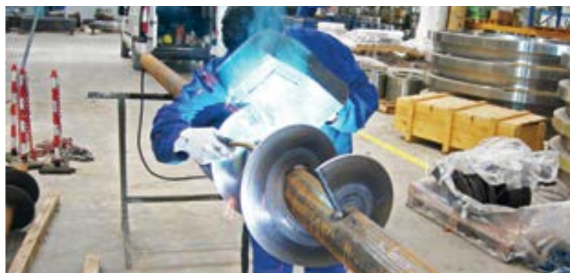
Figura F.1 - Saldatura di una spirale elicoidale su un palo PVC impiegando per sottofondare il basamento di un macchinario da 850 KN, installato dentro uno stabilimento metalmeccanico a Villamarzana (RO).
