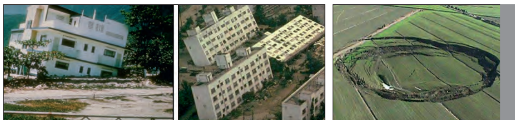
Figura 87. Esempi di sprofondamento di edifici a causa di sabbie liquefatte.
