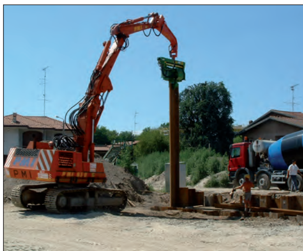
Figura 26. Macchina operatrice vibro infissione. - Figura 27. Macchina operatrice battipalo.
