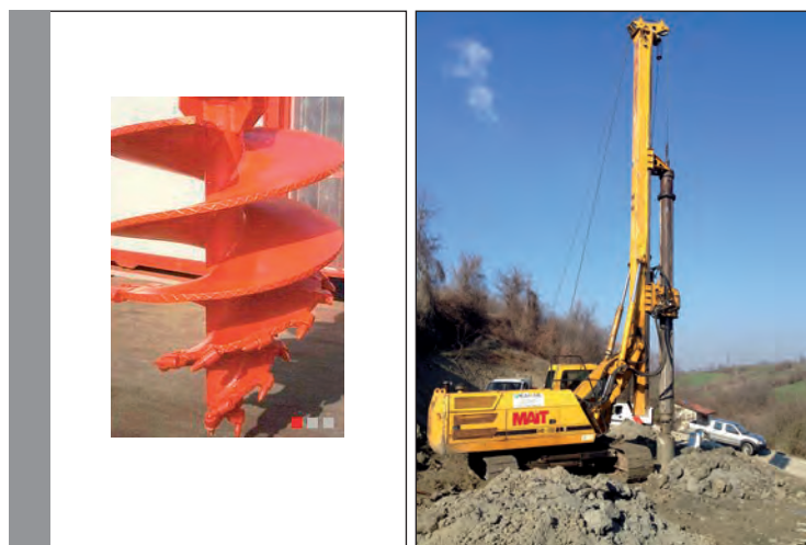
Figura 25. Particolare punta trivella e macchina operatrice.
