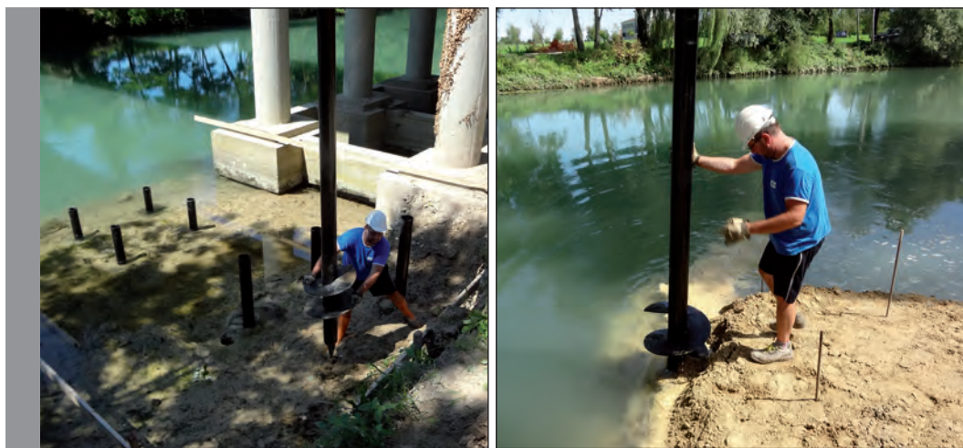
Figura 67. Infissione di pali Geopal® a sostegno delle pile di un ponte sul fiume Sile.
