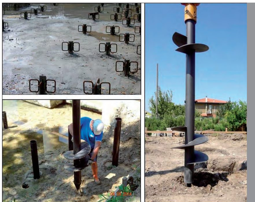
Figura 70. Fondazioni su plinto e platea sostenute da pali Geopal®.
