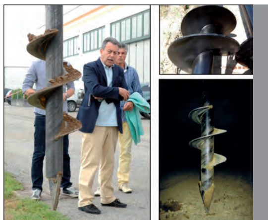
Figura 65. Fase di infissione; Particolare elica; Particolare punta a vite Geopal®.
