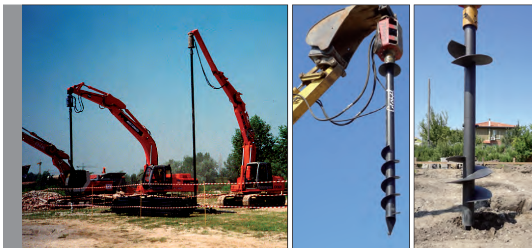
Figura 28. Macchine operatrici con avvitatore idraulico per pali a vite Geopal®.
